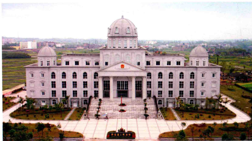
县法院机关在巴川镇白龙大道审判办公楼
