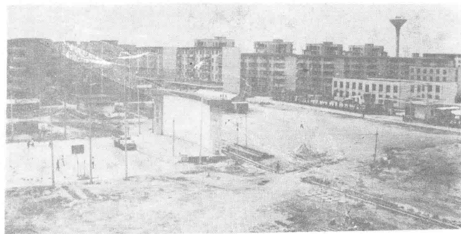
油坊岗二汽住宅区
