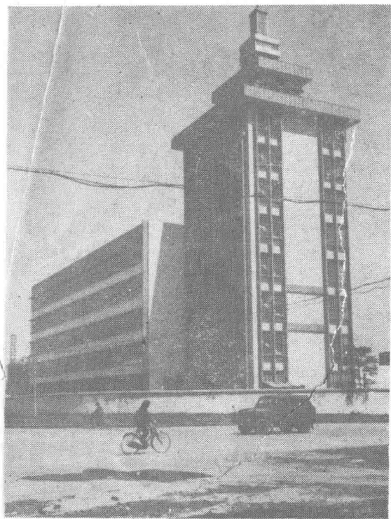
建设中的邮电通讯大楼
