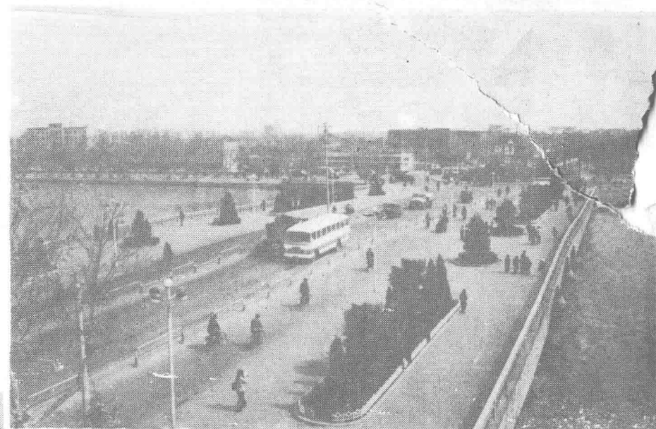
改建后的东门桥
