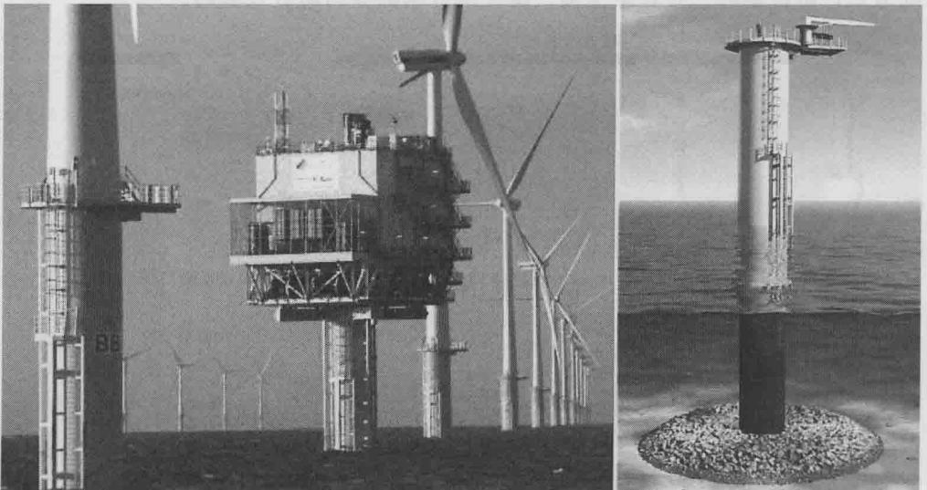
图1-2 单桩基础型式
