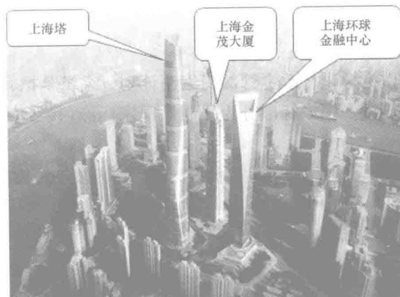
图 1-5 上海金茂大厦、上海环球金融中心、上海塔
