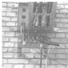
图 1.19 接地装置
