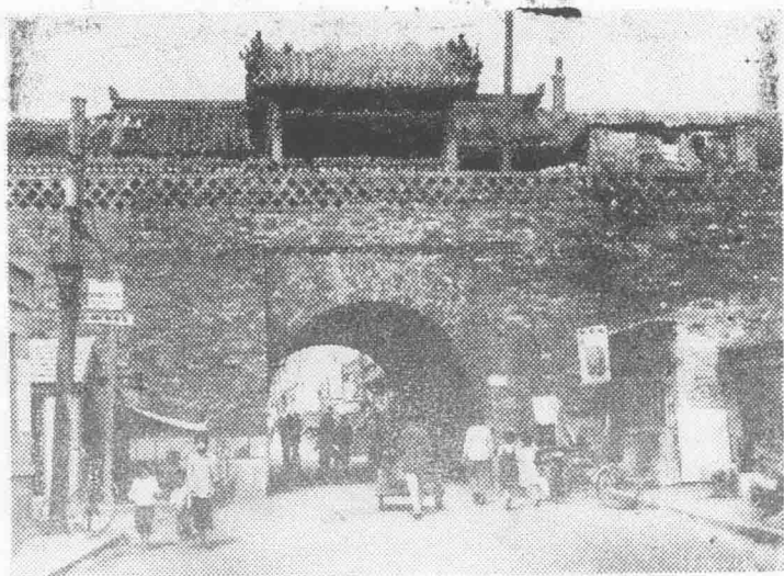
盖州城钟鼓楼
