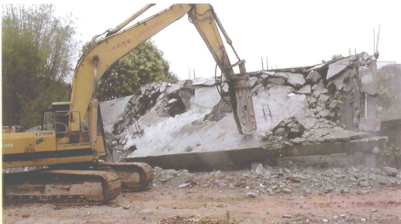
4月29日汝湖拆除现场
