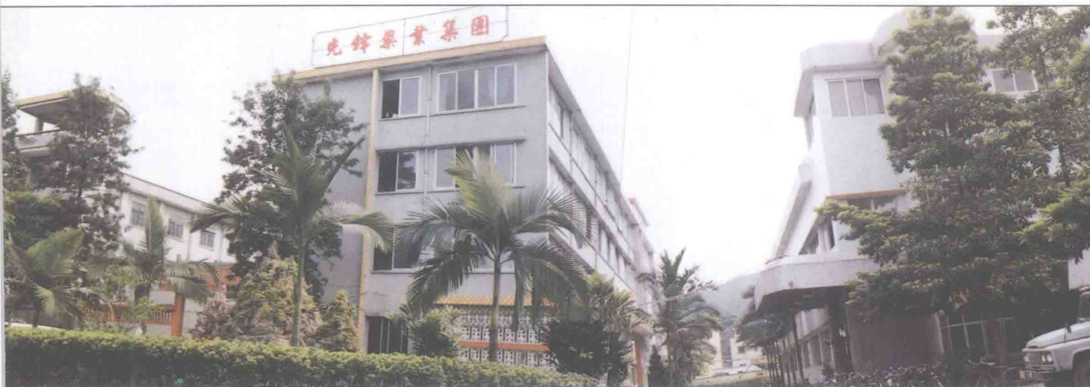
位於东江河畔的厂区
