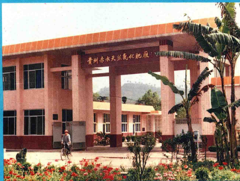
赤水天然气化肥厂办公楼大门
