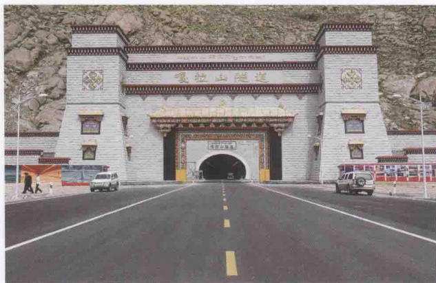
“两桥一隧”嘎拉山隧道口 (田志林摄 西藏日报社摄影部提供)
