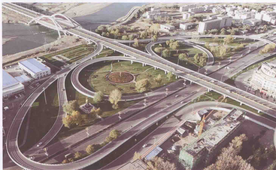
西藏第一座现代化大型立交桥——拉萨柳梧大桥
