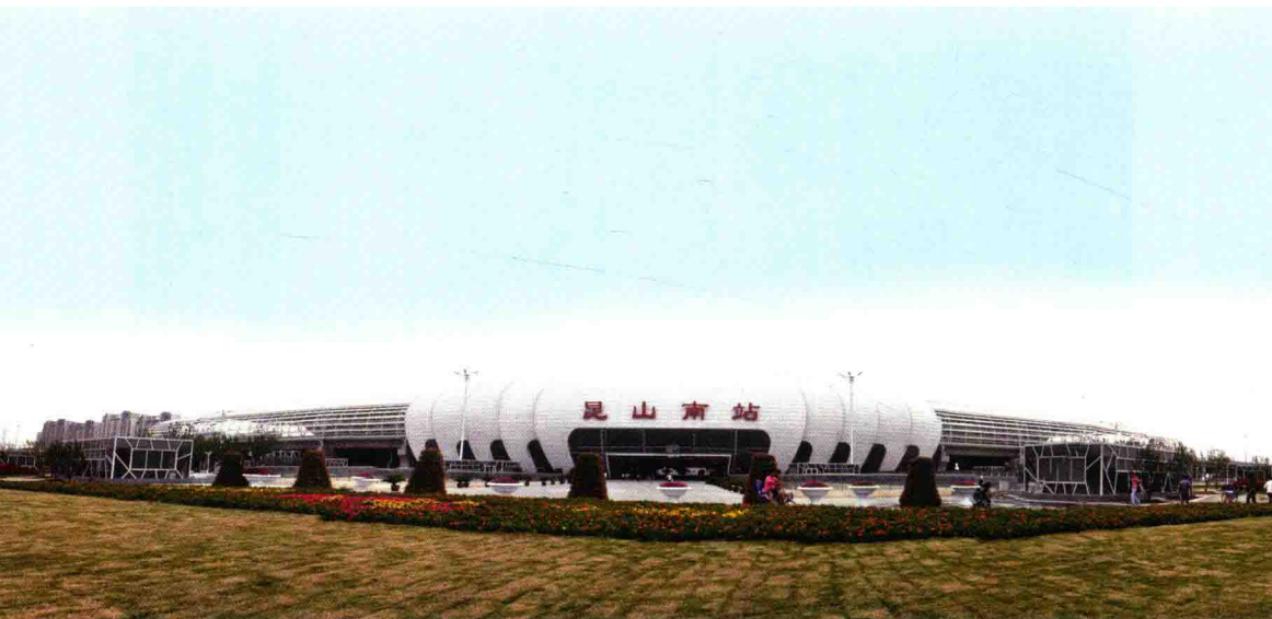
京沪、沪宁高速铁路昆山南站
