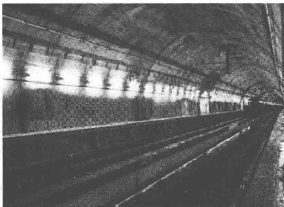
图 1.9 青函海底隧道
