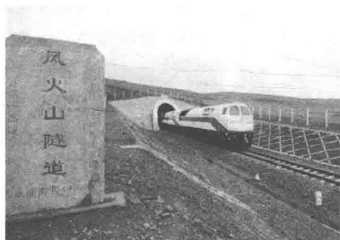
图 1.1 青藏铁路风火山隧道
