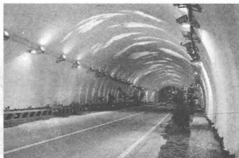
图 1.2 秦岭终南山公路隧道
