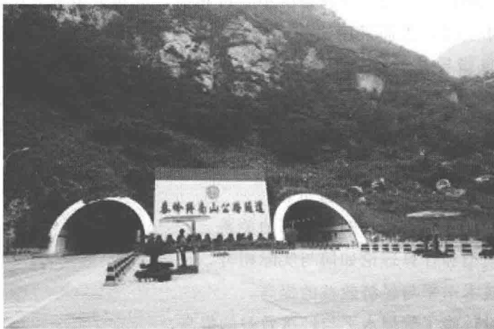
图 1.11 秦岭终南山隧道
