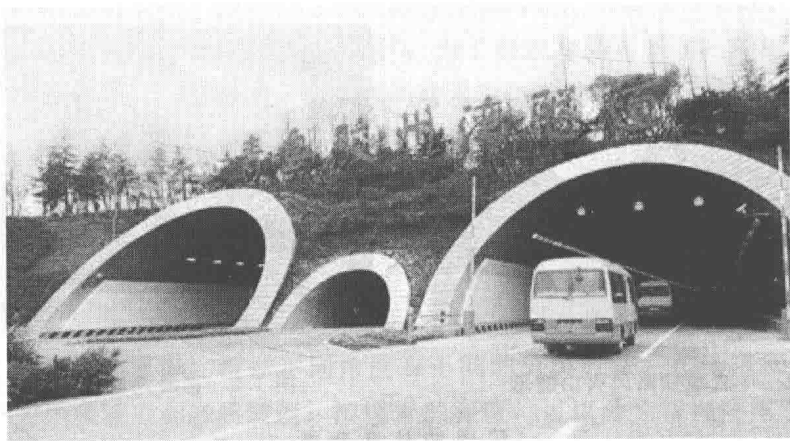
图 1.4 胶州湾海底隧道
