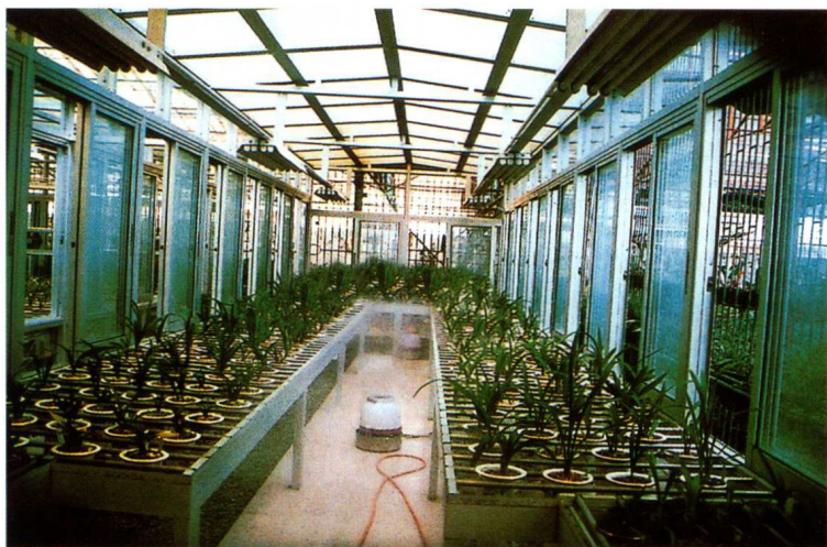
全封闭铝合金玻璃结构养兰温室
