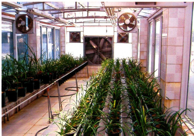
装置通风排气设施
