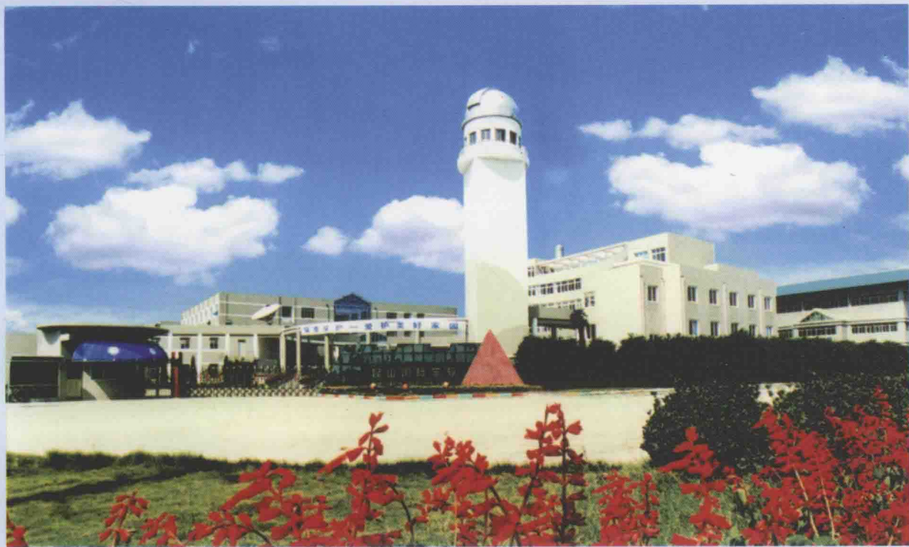
昆山国际学校青阳校区（1999年建）
