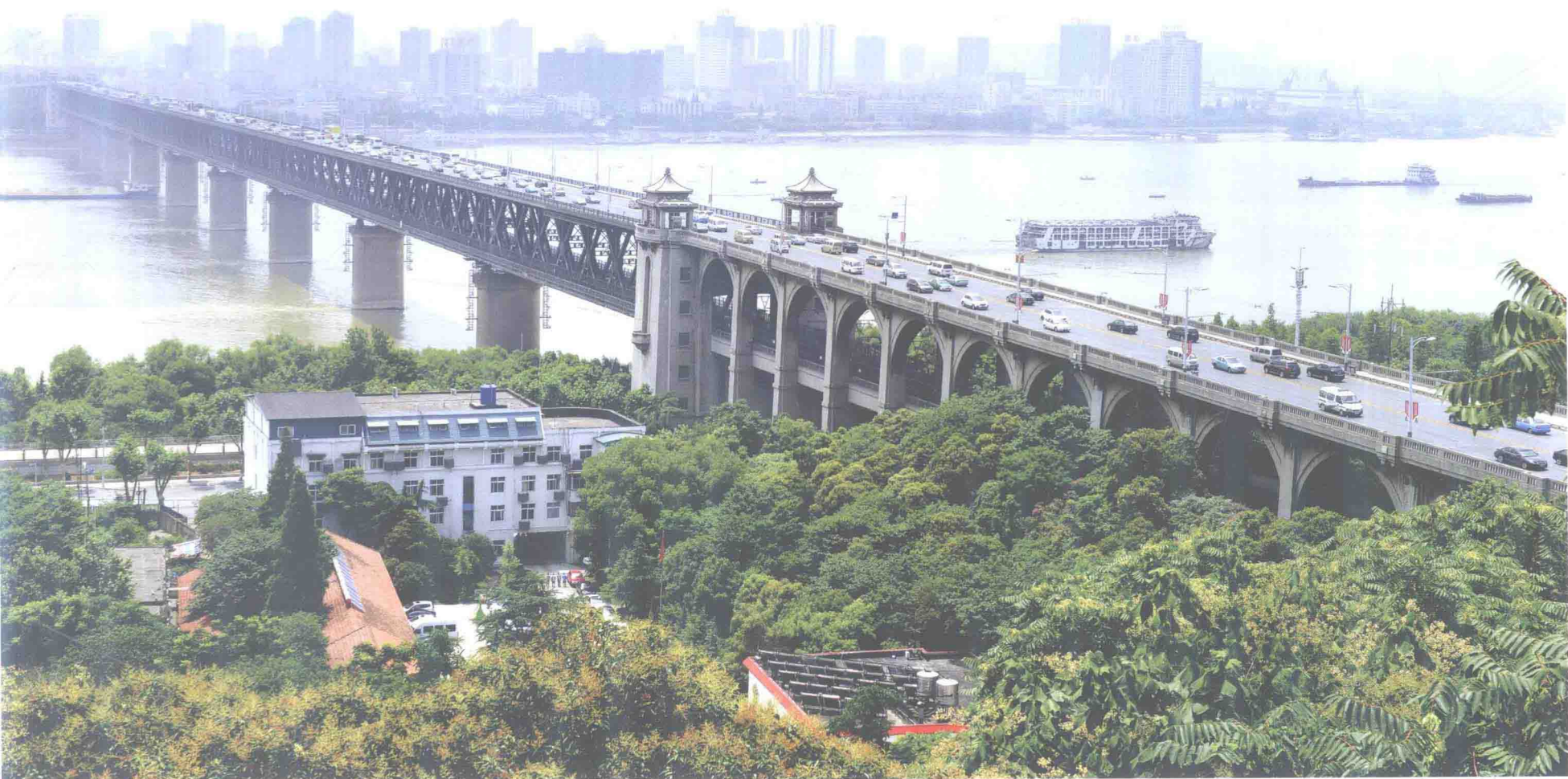
武汉长江大桥
