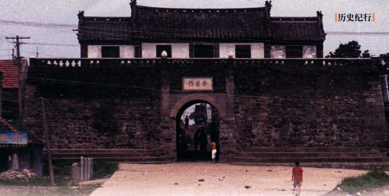
▲ 山东即墨雄崖所故城南门。雄崖所故城位于即墨城东北44公里处 的丰城镇，它是明代为防御倭寇入侵而修筑的。
