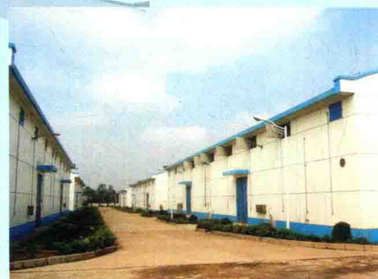
国家粮食储备库项目
