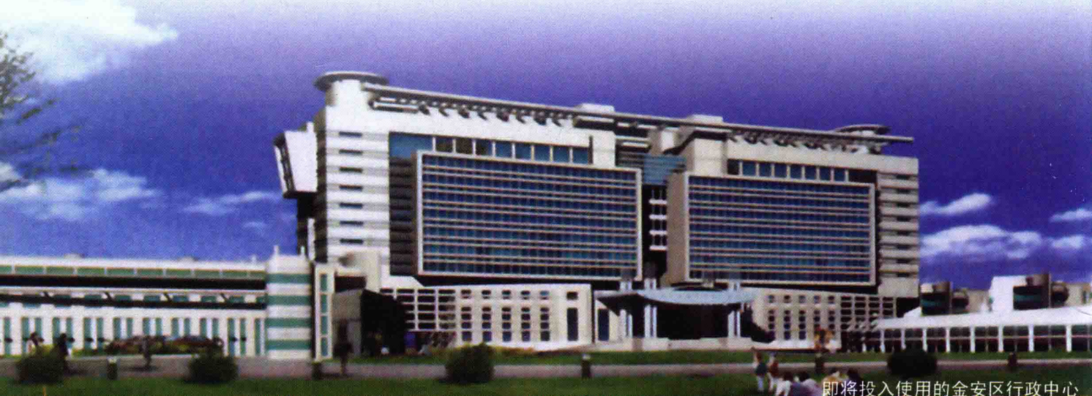
即将投入使用的金安区行政中心
