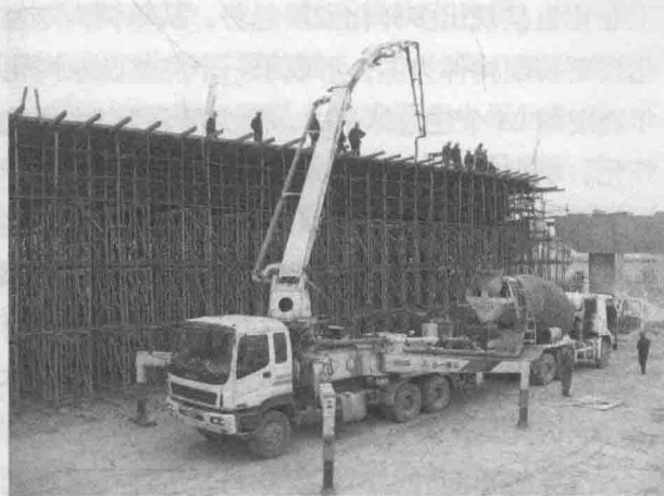
图 1-3 混凝土泵车与搅拌车进行浇筑作业
