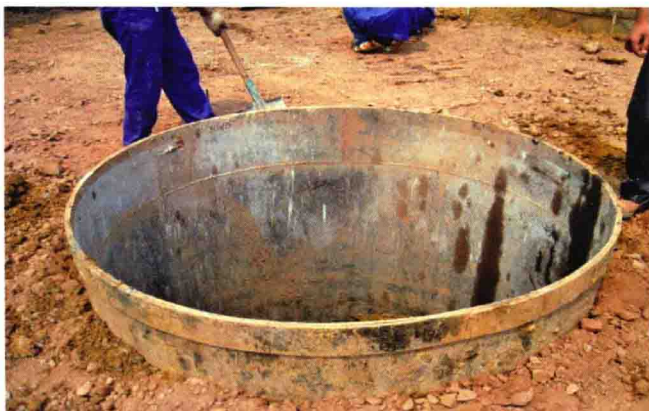
图 1-4 埋设钢护筒
