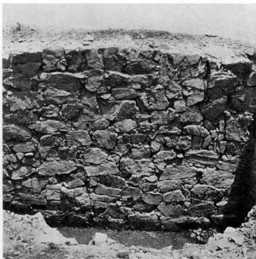
D429 石室未倒塌的下坡面北壁
