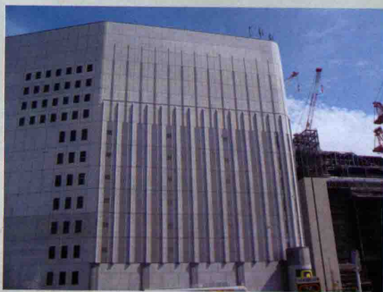
C07 日本大阪钢结构建筑的 PC 幕墙
