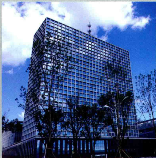
C02 沈阳兆寰 - 框架结构写字楼 - 安保大厦
