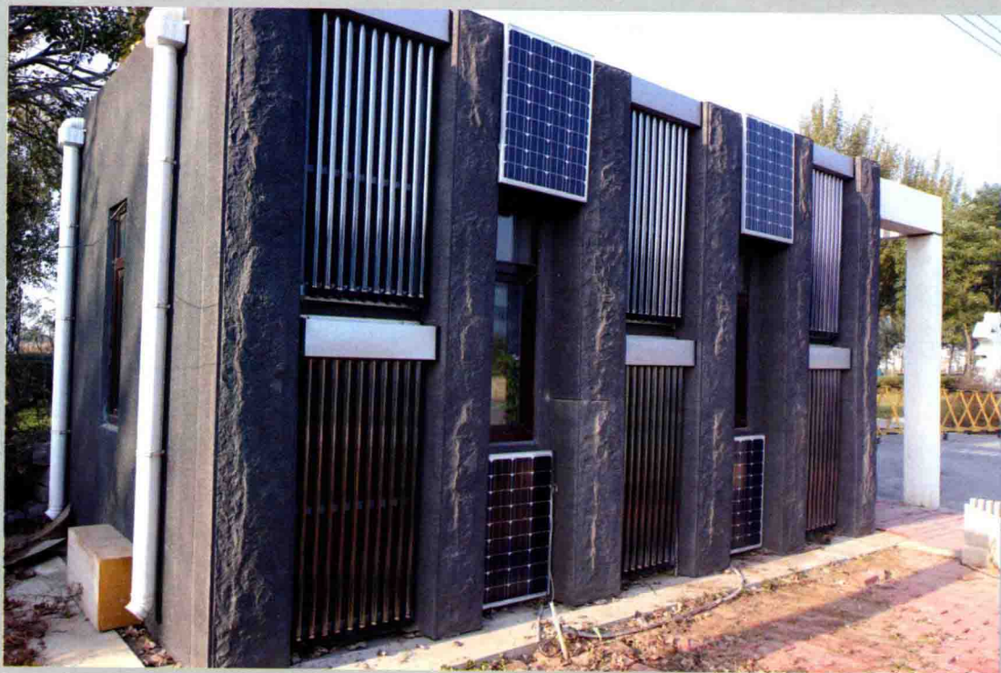
C05 沈阳兆寰 - 装饰保温结构一体化全装配式门卫房
