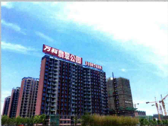
C03 上海城业 - 框架剪力墙结构住宅 - 万科翡翠公园
