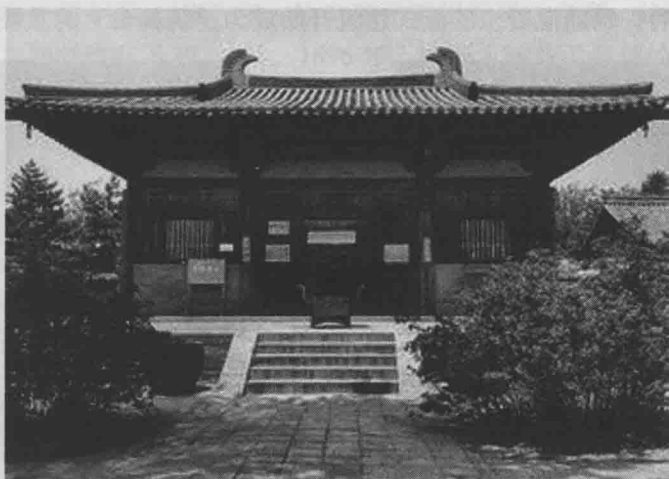
图 1.2-4 五台山唐代庙宇——木结构装配式建筑
