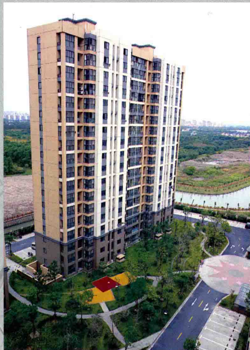
C04 上海住总 - 剪力墙结构住宅 - 浦江保障房
