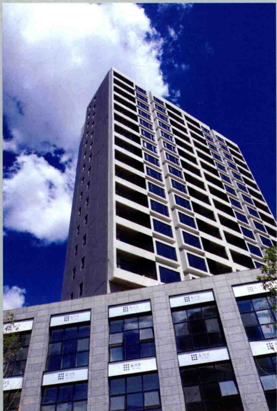
C01 沈阳兆寰 - 框架结构住宅 - 万科春河里
