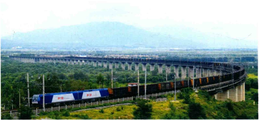
HXD1 型 9600 千瓦大功率交流传动电力机车在大秦线上牵引万吨重载列车
