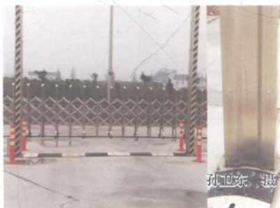
图 1-9 进入鸡场的车辆压力感应喷雾消毒通道（右侧为局部放大的喷雾装置）
