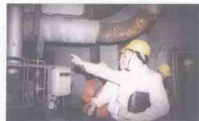
市质监局局长高富荣带来安全监察人员检查惠城发电厂的锅炉安全运行情况
