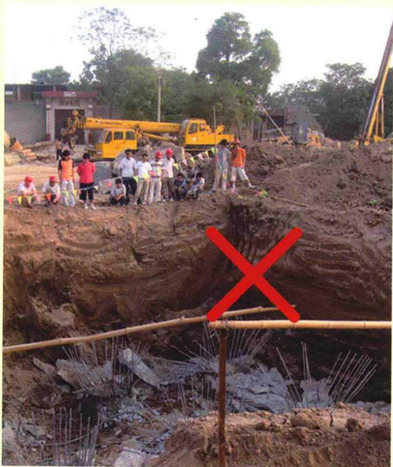
【案例】某施工单位基坑开挖未按规定进行放坡，存在安全隐患。
