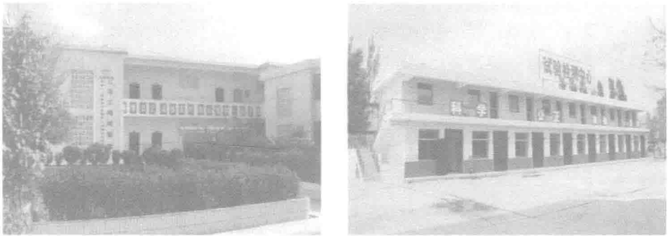
图 3.1.2 工地试验室租用房屋
