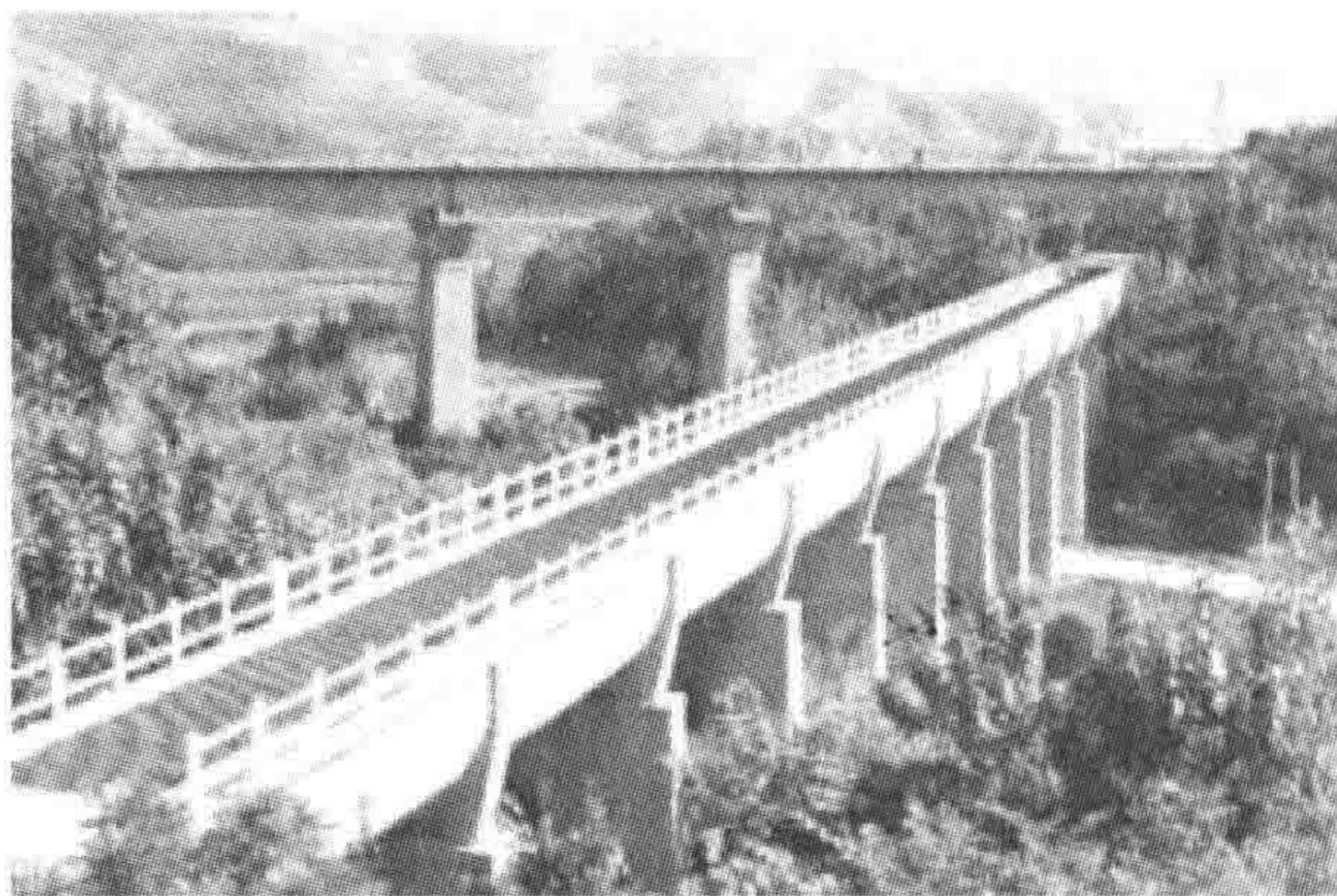
图 1-4 全封闭输水渡槽
