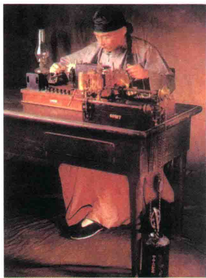
清末拍电报的还原图。桌上的两部电报机,左为老式的莫尔斯电报机,右为较莫尔斯电报机更先进的韦斯登电报机。
