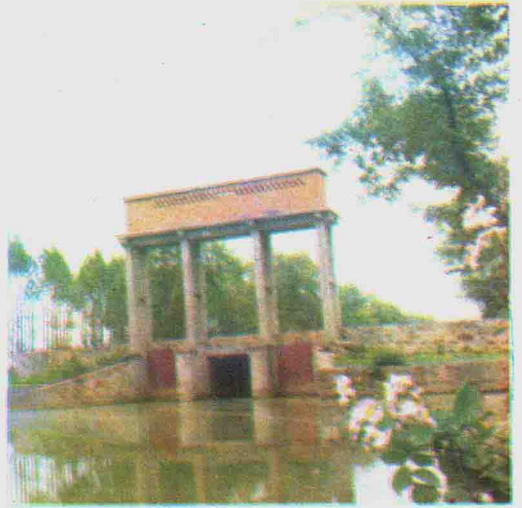
↑ 四 线 港 节 制 闸
