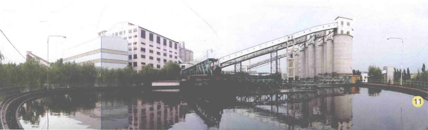
准能选煤厂洗煤水闭路循环系统 - 沉淀池
