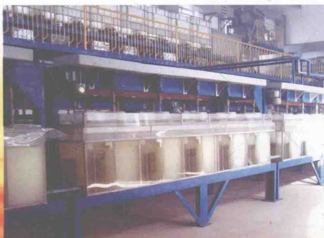
2007年12月8日，棒材厂新高线工程竣工投产
