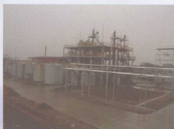
化工中试基地
