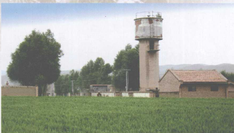
人饮井及水塔
