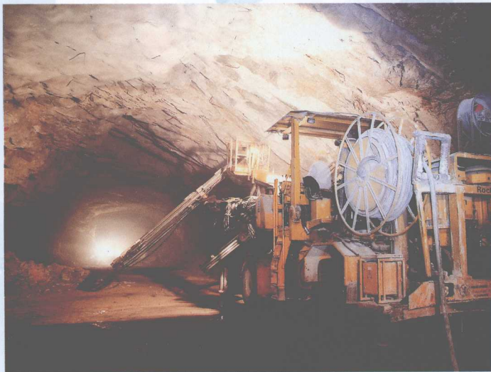
四川瀑布沟水电站泄 洪洞地下工程施工
