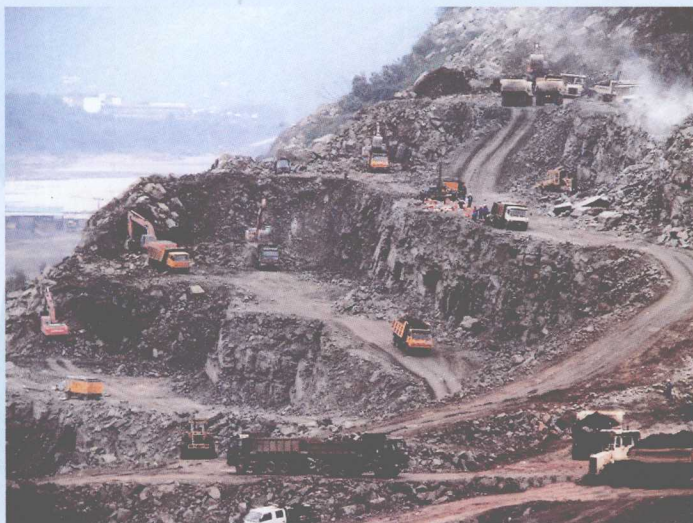
金沙江向家坝水电站开挖施工
