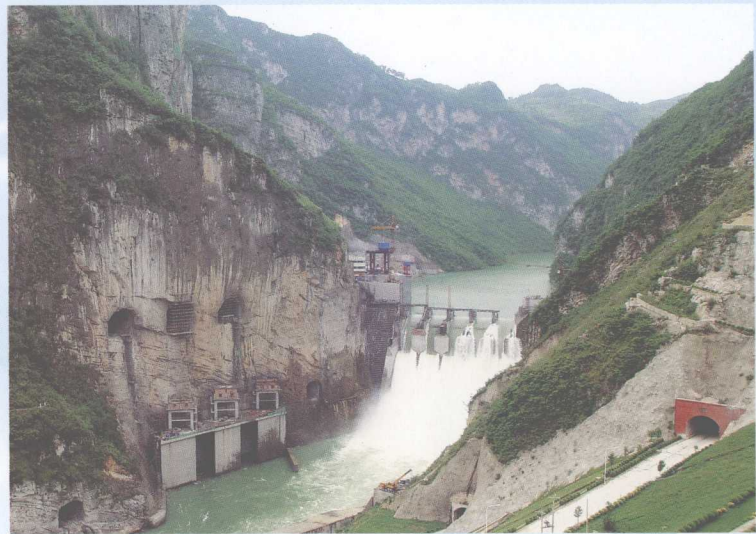
贵州乌江索风营水电站
