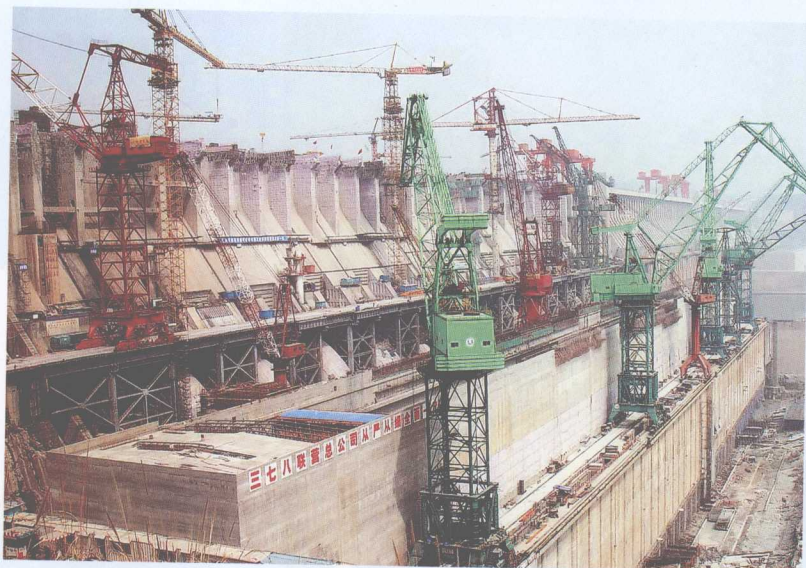
三峡水电站右岸厂房工程正在紧张施工
