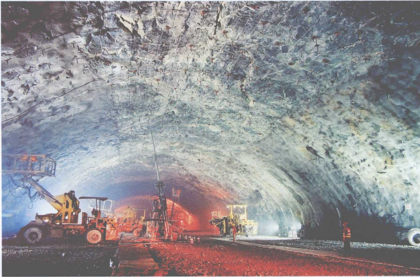
三峡水电站右岸 地下厂房施工
