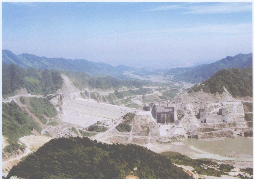
四川紫坪铺水电站厂房施工
