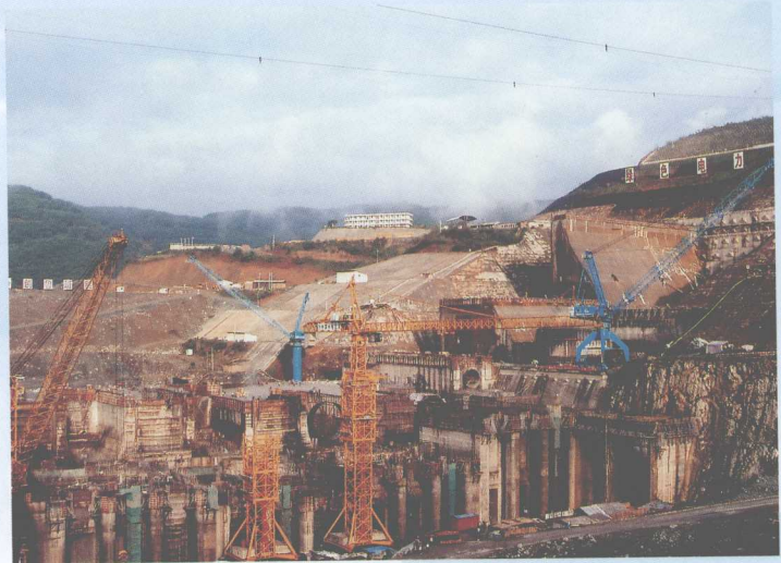
云南景洪水电站施工现场
