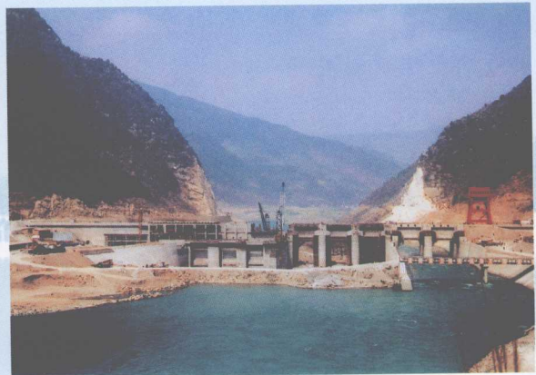
四川紫兰坝水电站
