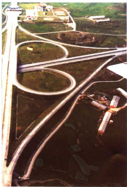
桂南高速路与机场路立交（何志勤摄）
