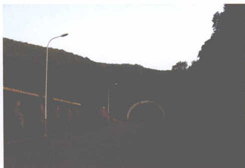
6月7日，单线总长7.2公里、高8米，开挖跨度16米、紧急停车带宽度19米的宁淮高速公路老山隧道工程全线贯通。这是全省高速公路建设史上规模最大、里程最长的隧道工程
