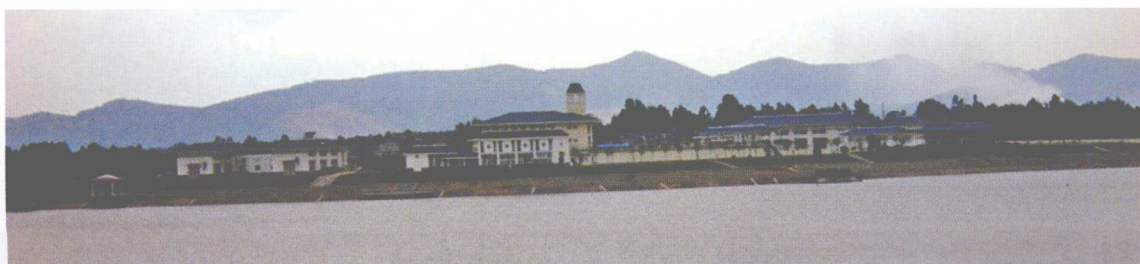
11月建成的三岔水厂，日供水能力6万立方米，向桥林、乌江、石桥、星甸、汤泉、永宁6镇及区内的老山林场、汤泉农场、驻区部队和大吉公司等单位统一供水，彻底解决了20多万群众吃水难问题
