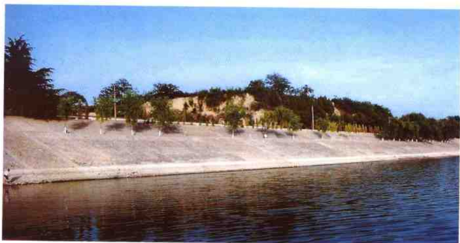
平陆县茅津护岸工程
