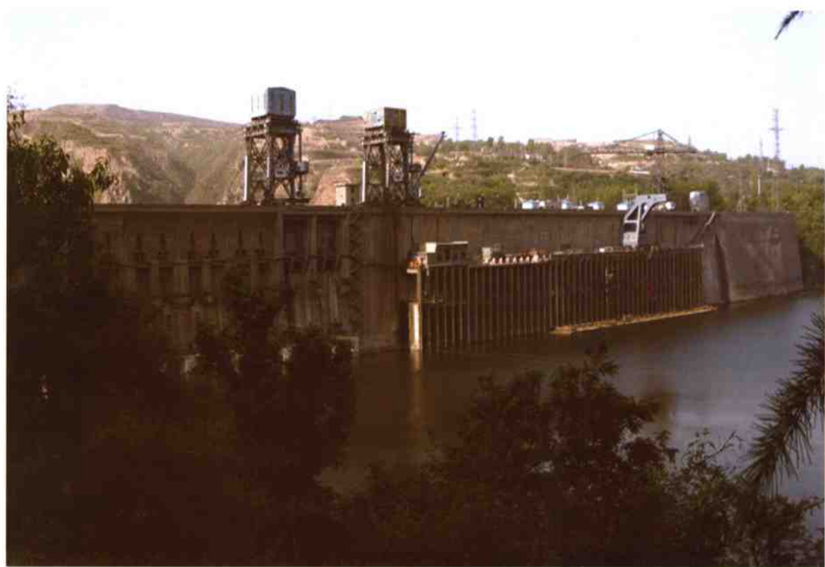
三门峡水利枢纽全景
