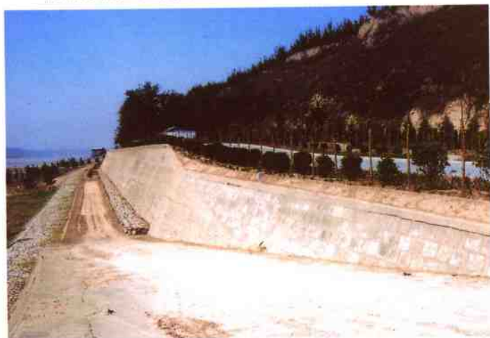
平陆县车村护岸工程
