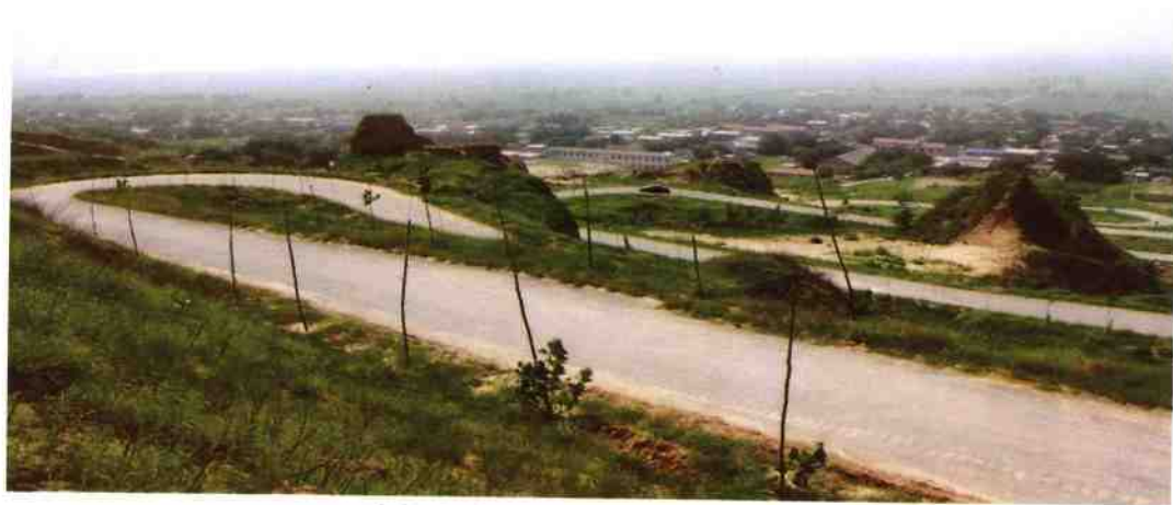
为解决库区移民交通修的公路
