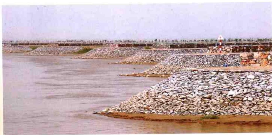
芮城县东垆裁弯试验工程
