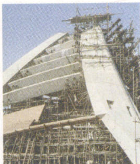
施工中的屋顶
