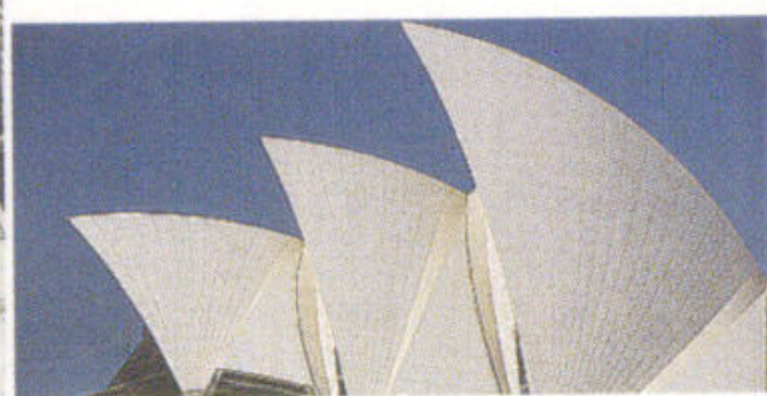
完成后的屋顶
