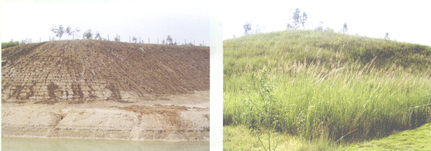
图 1-5 某公路边坡水土流失治理前后对照
