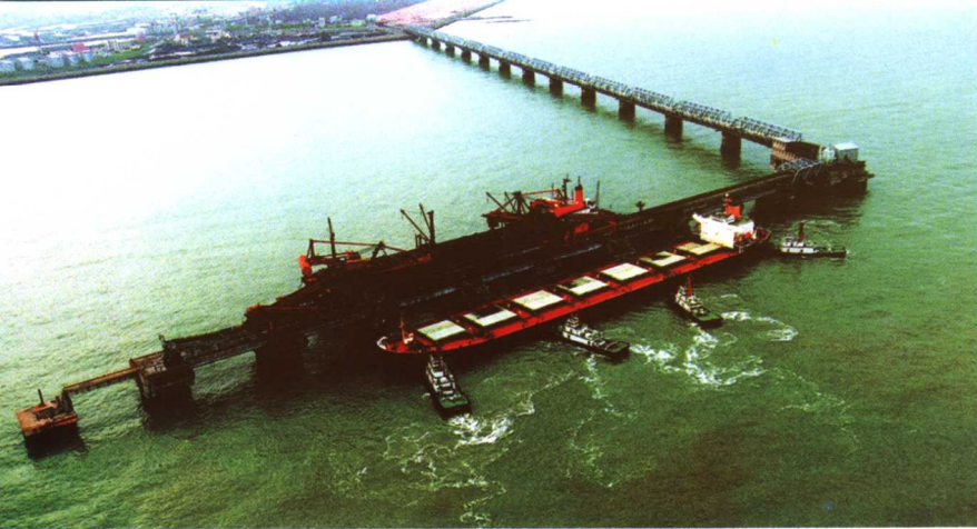
日照港15万吨煤炭泊位
