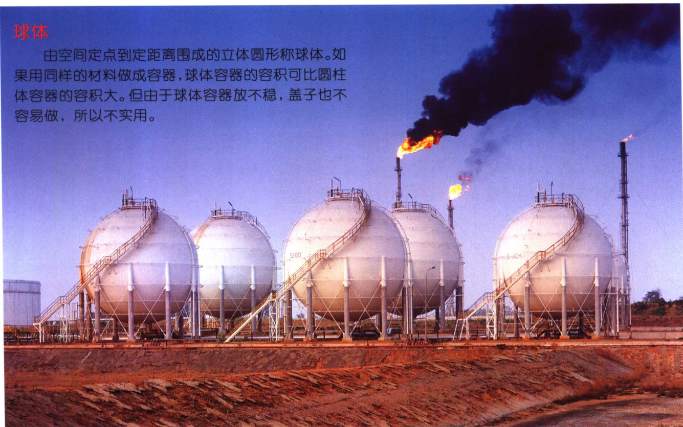
球形的储气罐
