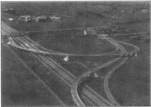
图 1.2.2 辽宁省沈大高速公路大石桥立交,3 肢 3 层互通
