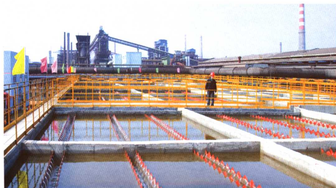
广西钢铁产业人才小高地柳钢污水处理一期工程投入使用
