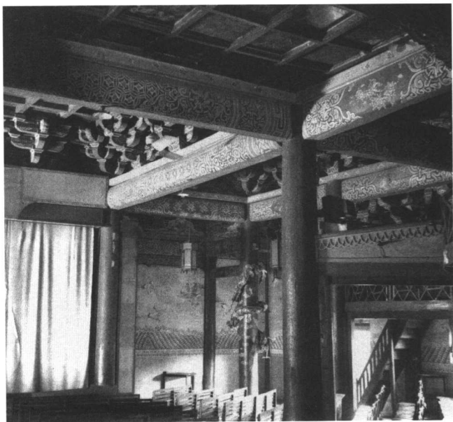
城隍庙大殿明代梁柱斗拱
