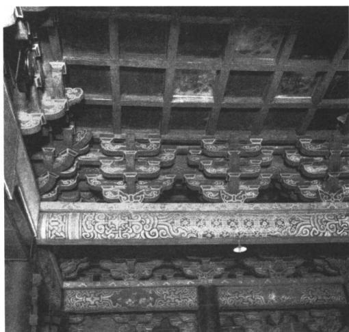
城隍庙大殿明代梁柱斗拱
