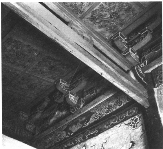
城隍庙大殿明代梁柱斗拱
