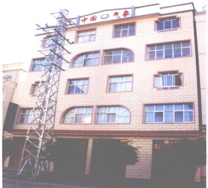
南涧县气象局住宅楼
