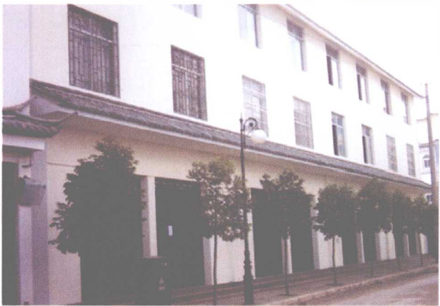
巍山县气象局住宅楼
