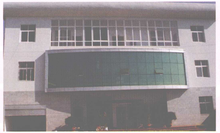
祥云县气象局综合办公楼
