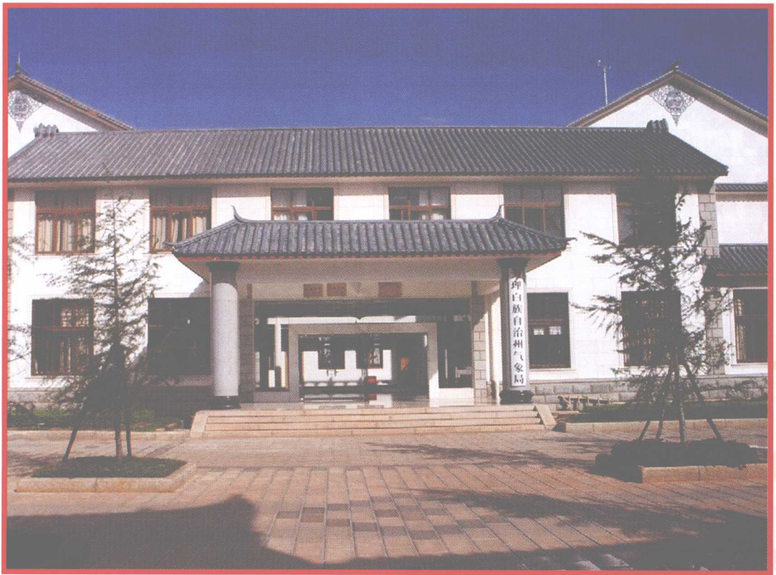
大理州龙山行政办公区气象局办公楼
