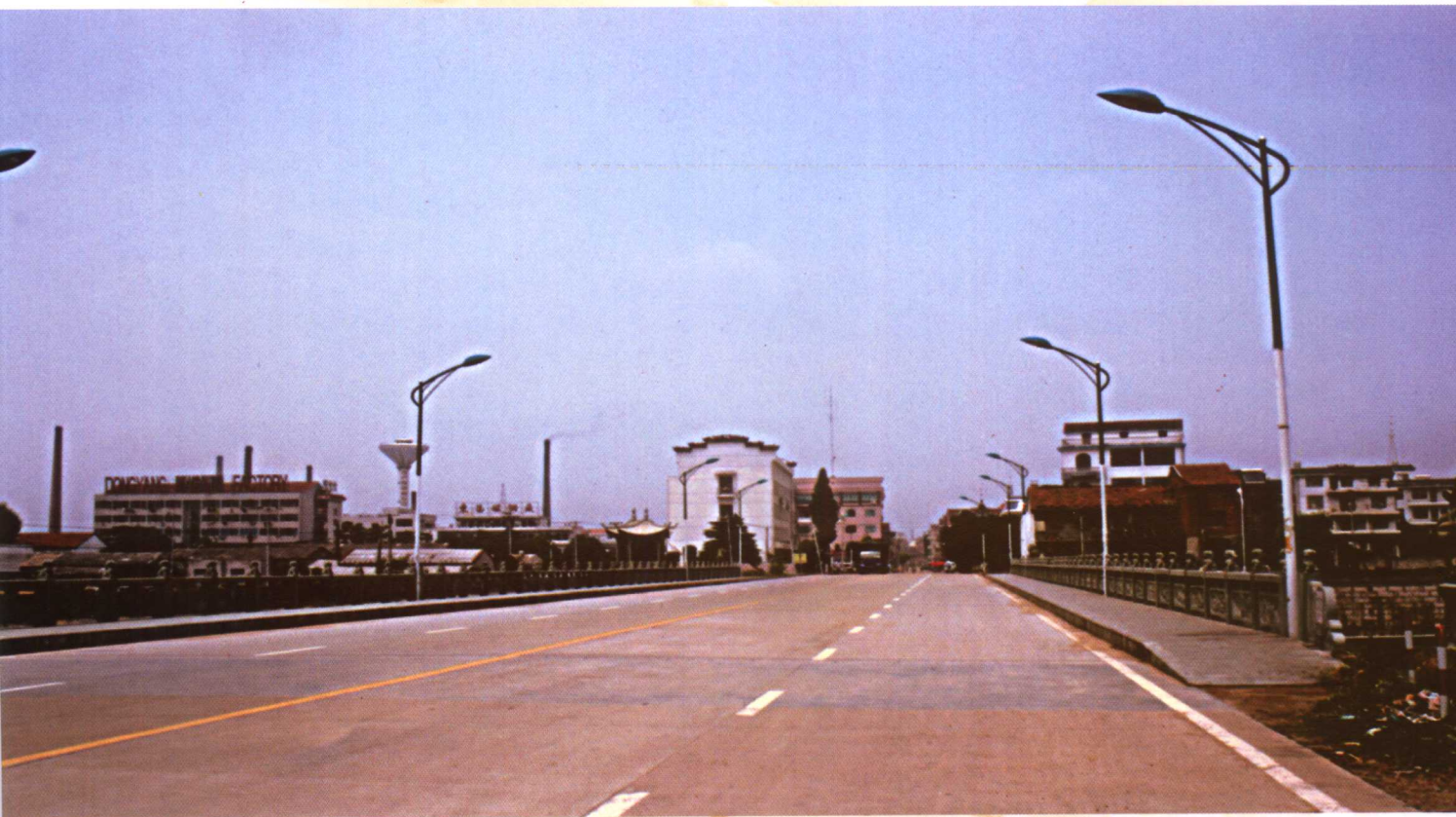
※ 采卢大桥全景 (张照香 摄)
