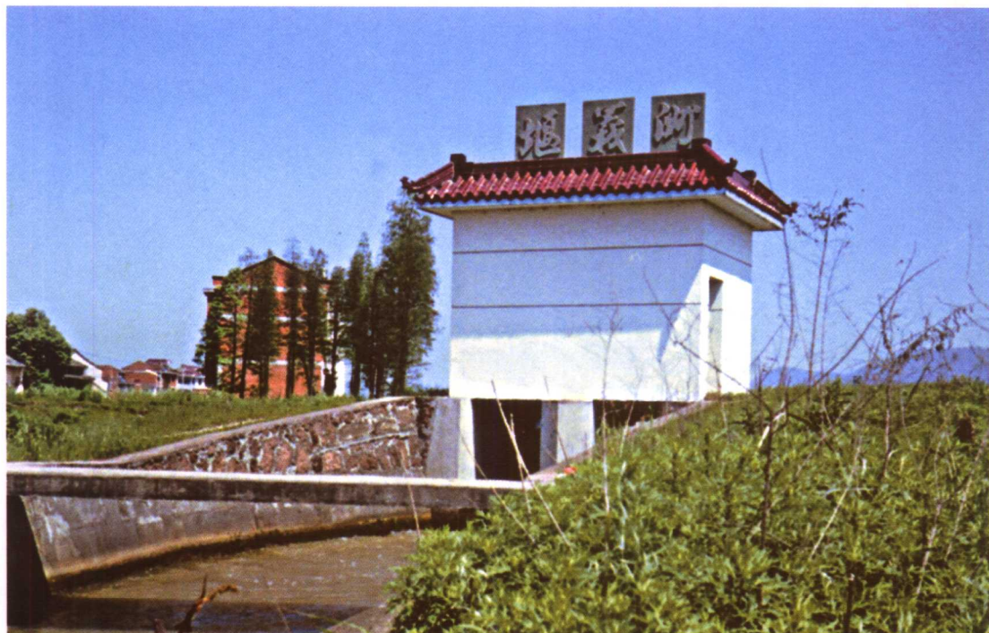
※ 洲义堰启闭机房 (蔡锦涛 摄)
