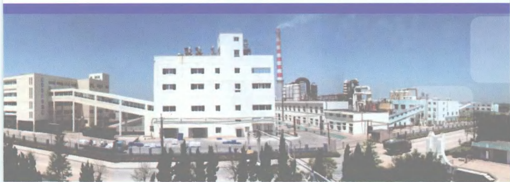
生产厂区全景
