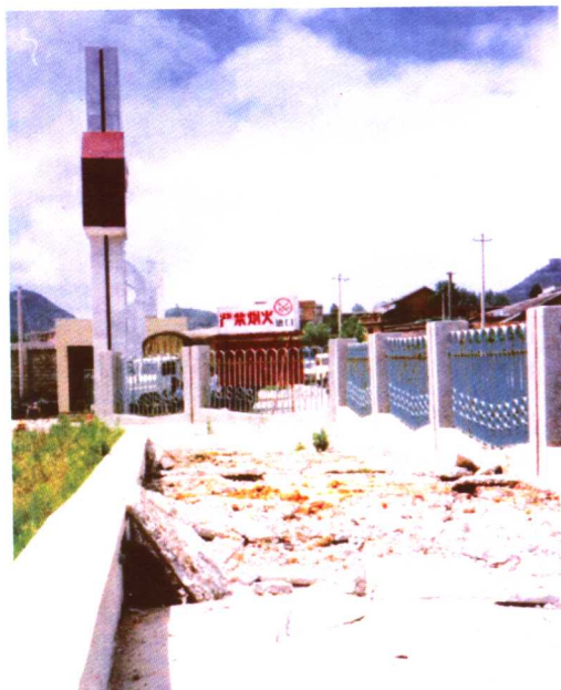
1989年4月，安顺东郊加油站遭雷击，被 击处为地下油库顶。雷电是沿通风管道进入的 （图片由贵州省气象学会秘书处提供）
