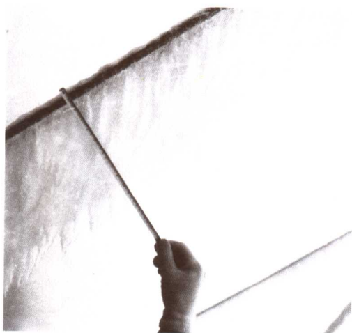
1975年1月4日，贵州100千伏水城重冰区八担山垭口，导线覆冰长径达200毫米，乳白色，为雾凇雨凇混合体，以雾凇为主，椭圆形，鸡毛投影状（图片由贵州省气象档案馆提供）
