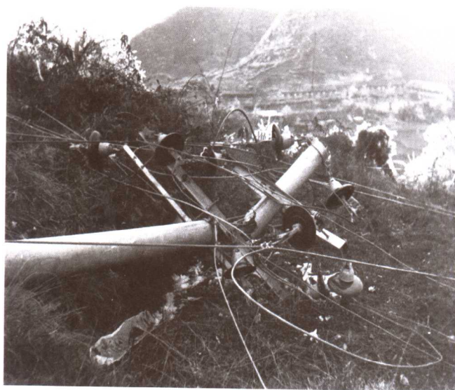
1975年1月4日，贵州100千伏水城重冰区八担山垭口，导线覆冰长径达200毫米，乳白色，为雾凇雨凇混合体，以雾凇为主，椭圆形，鸡毛投影状（图片由贵州省气象档案馆提供）
