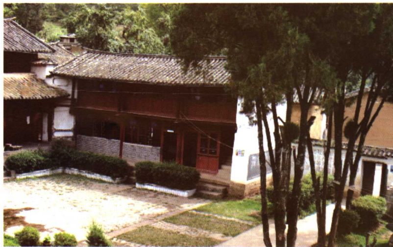
新民村原兔峨土司衙署遗址(文革期间搞“破四旧” 衙门建筑被捣毁,后重新建盖学校使用至今)
