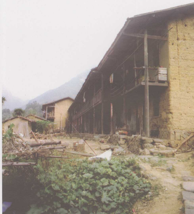
红军活动地罗汉里的房屋被国民党烧了380间。解放后永泰县人民政府重建村居。
